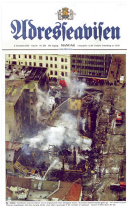
8. desember 2002 skades et helt kvartal i byen i brann. Næringslivets Hus får kraftig banesår, men består. Faksimile fra Adresseavisen
